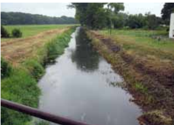
Begradigte Fließstrecke mit Gewässerunterhaltung an der Nuthe bei Walternienburg
