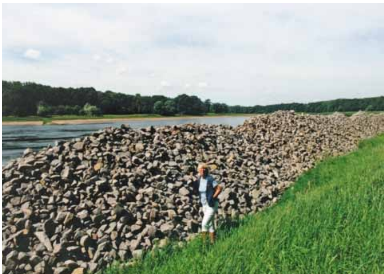
Elbe; Schotter für Uferbefestigung
