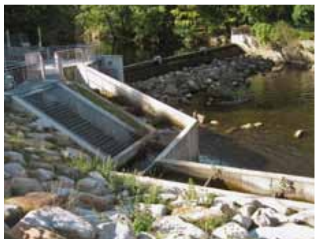
Schau-Wasserkraftwerk mit Fischtreppe im Bodetal
